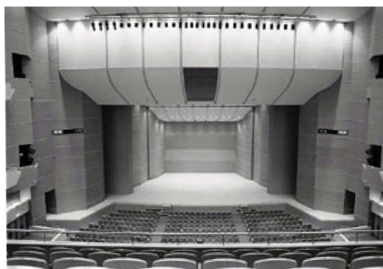
梨花ホール（音響反射板設置）
